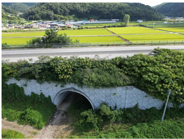
주변영향인자(성토부, 상부 도로) 상부 성토부 상태현황
