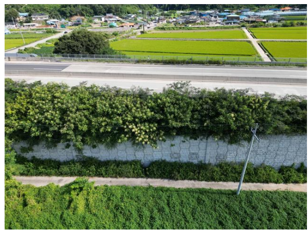
주변영향인자(성토부, 상부 도로) 상부 성토부 상태현황
