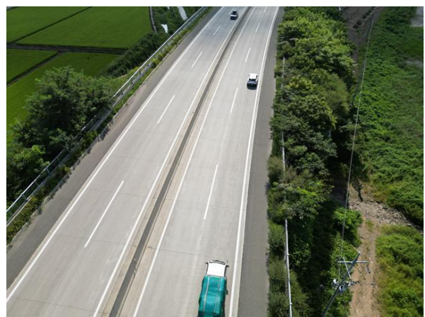
주변영향인자(성토부, 상부 도로) 상부 도로 포장 상태현황
